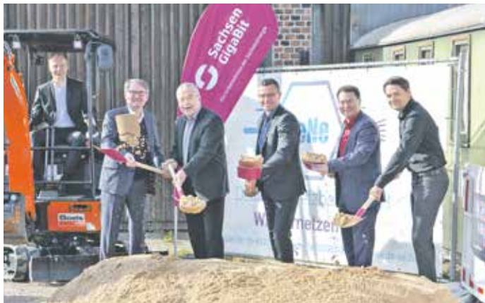
Projektstart mit symbolischem ersten Spatenstich v.l.n.r.: im Bagger: Dr. Frank Brinkmann (Vorstandsvorsitzender SachsenEnergie), Jens Schaller (Geschäftsführer SachsenGigaBit GmbH), Landrat Michael Geisler, Ralf Rother (Bürgermeister Wilsdruff), Steffen Lehmann (Referatsleiter Staatsministerium für Wirtschaft, Arbeit und Verkehr), Sven Paschold (PwC)
